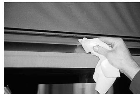
Choisir l'épaisseur du trait, de façon à ce qu'en pressant le TOP-RAIL sur le support, un peu de colle apparaisse en haut et en bas, garantissant une bonne étanchéité.
