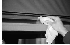
Die Strangdicke wird so gewählt, dass beim Aufdrücken der TOP-RAIL auf den Untergrund oben und unten der Kleber ein wenig hervortritt, um eine gute Abdichtung zu gewährleisten.
